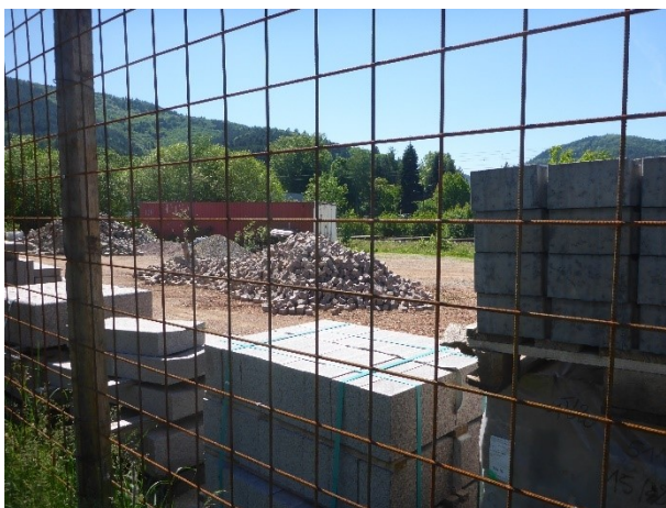
Abbildung 12: Blick auf die Materiallager im Süden des UG, im Hintergrund die Gleise der Schwarzwaldbahn
