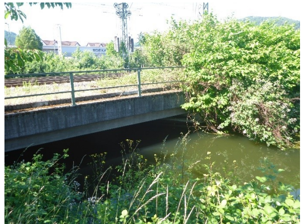
Abbildung 17: Bahnbrücke über den Gewerbekanal am südlichen Rand des UG
