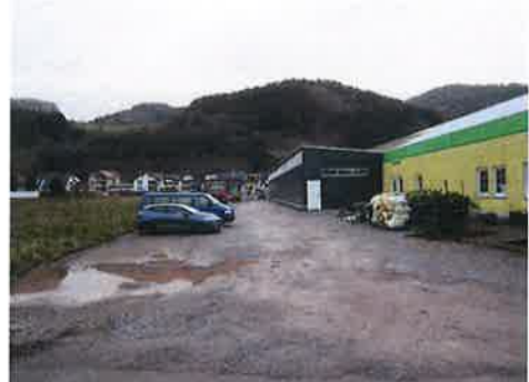
Westlich angrenzend an die Verkaufshalle wird eine neue Lagerhalle errichtet. Im Bildhintergrund ist die Wohnbebauung von Bollenbach zu sehen
