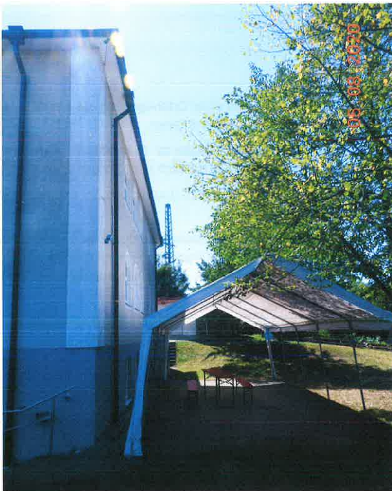
Abbildung 4: Bereich der Gebäudeerweiterung; das Zelt deckt die ungefähre Breite des geplanten Gebäudes ab; rechts daneben der Überhang der 3 vorhandenen Linden
