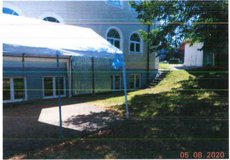
Abbildung 3: Bereich der Gebäudeerweiterung
